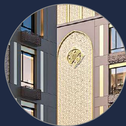
Фасад - композитные алюминиевые панели
