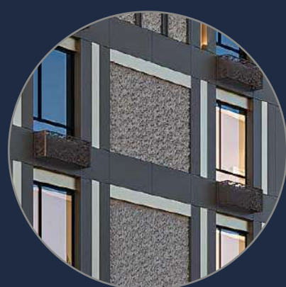
Окна - алюминиевый профиль европейского производства, однокамерный стеклопакет
