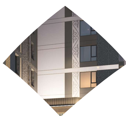
Фасад - композитные алюминиевые панели, клинкерная плитка и камень
